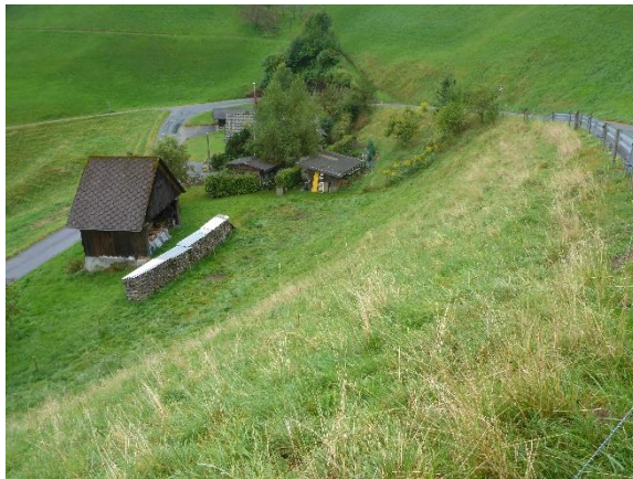
C: Blick von der Strasse auf das bestehende Gebäude auf Parzelle 1282 am Hangfuss.
