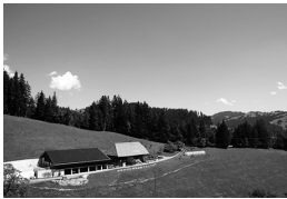
Förderung Solarstrom Emmental Projektbeitrag à fonds perdu, Bereich Industrie
