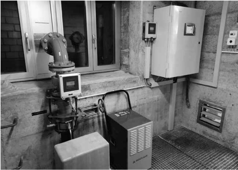
Im Reservoir Blasen wurde ein Steuerungsschrank, Luftentfeuchter sowie Wasseruhren für Ein- und Auslaufmengenmessungen installiert.
