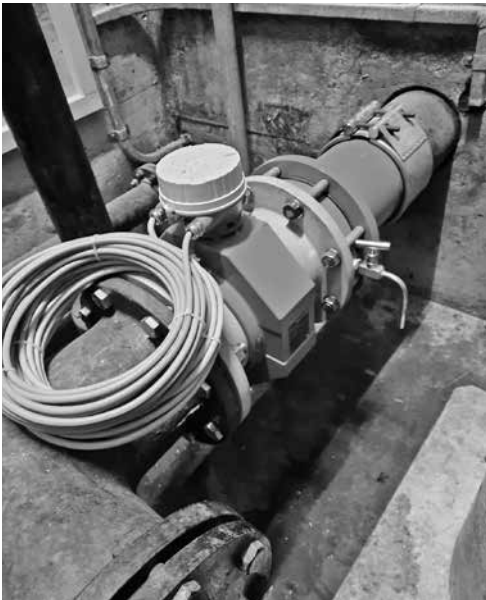
Im Reservoir Blasen wurde ein Steuerungsschrank, Luftentfeuchter sowie Wasseruhren für Ein- und Auslaufmengenmessungen installiert.
